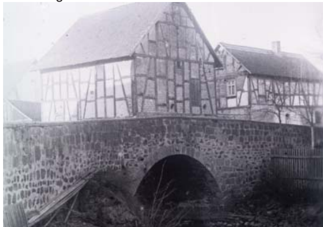
Schmidbrücke vor dem Umbau
