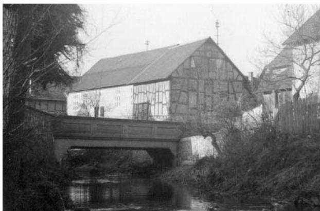
Schmidbrücke nach dem Umbau
